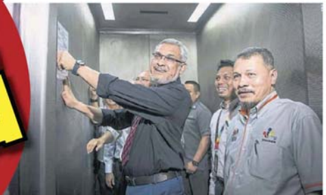
■克灵芝人民组屋升降机之前因故障造成8人从5楼坠下受伤事件，如今升降机已经修复并投入运作。
